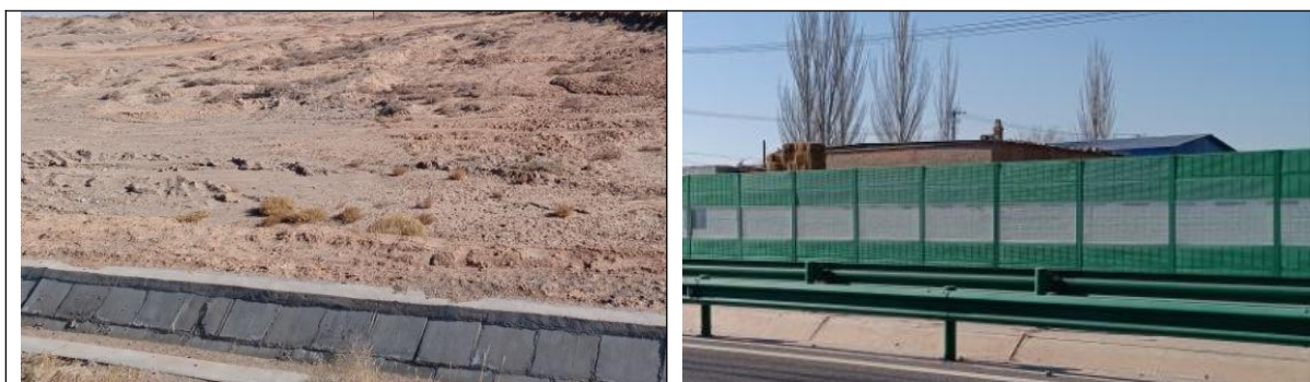
图 2-4 排水工程建设情况
