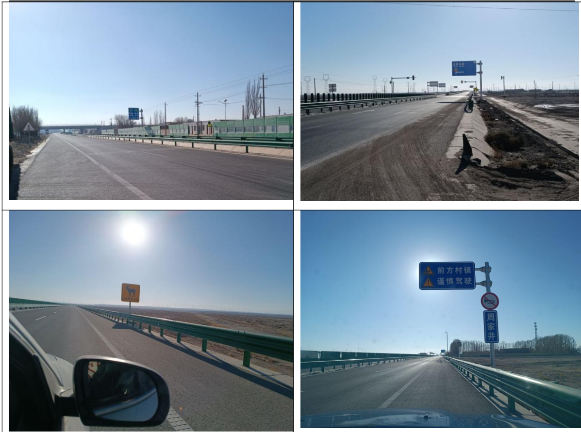
图 2-5 安全设施建设情况
