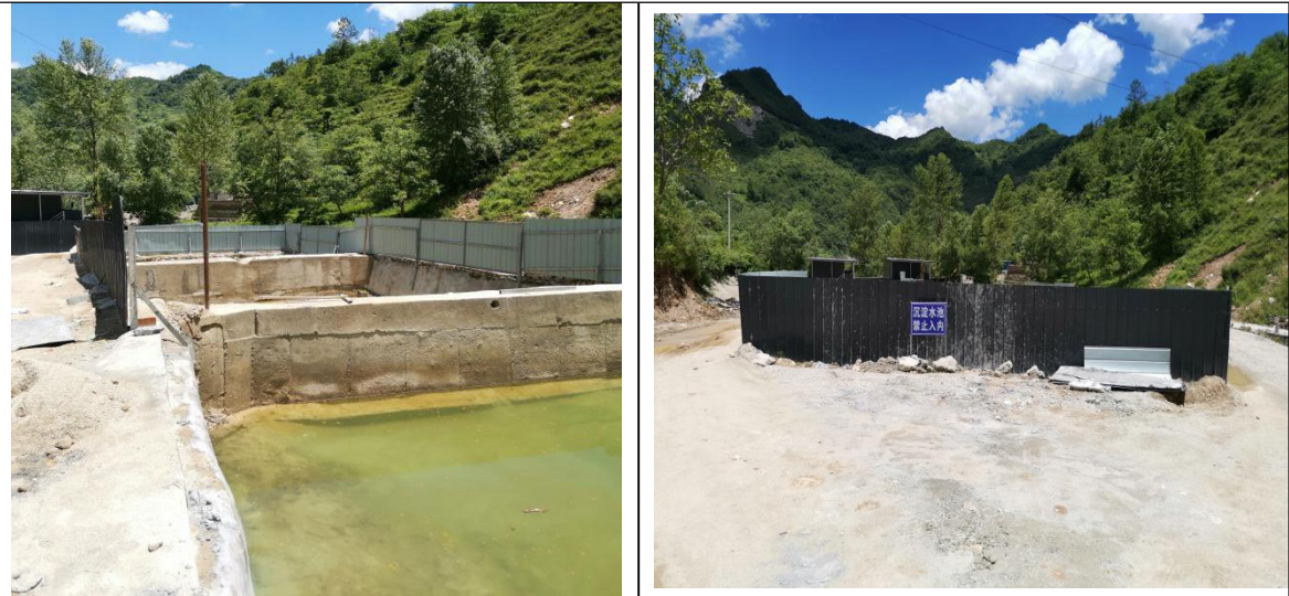
三级防渗沉淀池
