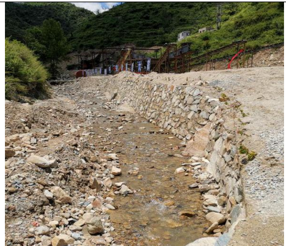
河堤维修加固
